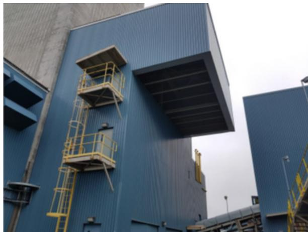
Afin de réduire la contribution sonore du ventilateur, un traitement des parois internes du bâtiment a été réalisé en y ajoutant un absorbant acoustique. Ce traitement a permis de convertir le bâtiment en plénum acoustique absorbant les ondes sonores avant que celles-ci ne se propagent à l'extérieur du bâtiment.
