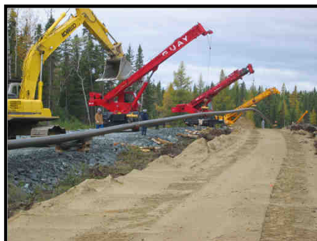
Mise en terre du pipeline
