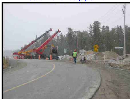
Installation du pipeline
