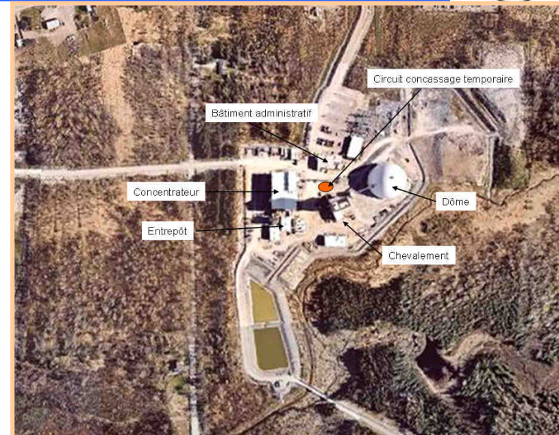
Positionnement du circuit de concassage temporaire
